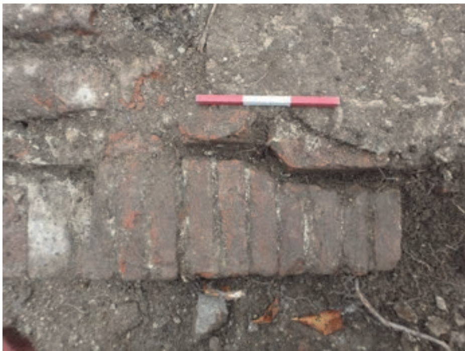
Afb. 5.19. Detail van de vorige afbeelding met het zuidelijke deel van de rollaag. Te zien is dat de opgaande baksteen aansluitend op de rollaag onder een hoek van 45 graden is afgeschuind. De stenen van de rollaag volgen ook de schuine hoek van die baksteen. Dit deel van het metselwerk zal onderdeel hebben uitgemaakt van de dagkant van een (geprofileerde) deuropening.
