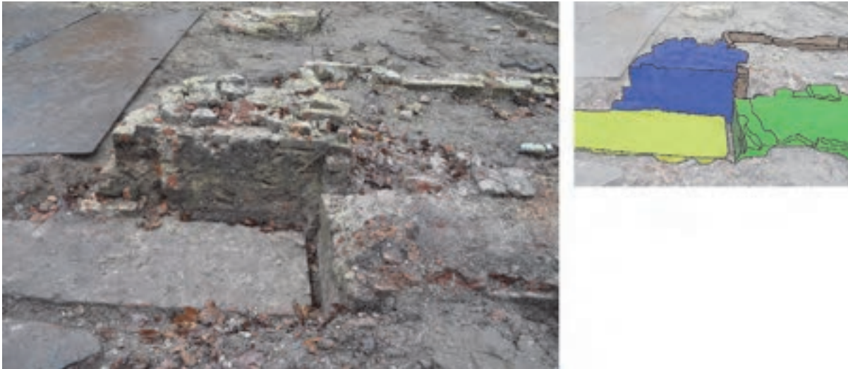
Afb. 5.17. Detail van de aansluiting van de westgevel op de zuidelijke kolom. Dit is het detail aan de bovenzijde van de afbeelding hiervoor. De oorspronkelijke westgevel is op de inzet in groen aangegeven. Deze lijkt afgehakt te zijn (donkergroen vlak). Het metselwerk van het aansluitende deel (geel) is niet in lijn met de oorspronkelijke westgevel geplaatst, maar wel tegen de uit de bouwtijd stammende kolom (blauw). Waarschijnlijk was de westgevel ter plaatse van de middenbeuk zo sterk verzakt, dat integrale nieuwbouw noodzakelijk was. In bruin is op de inzet het metselwerk van de grafkelder aangegeven.
