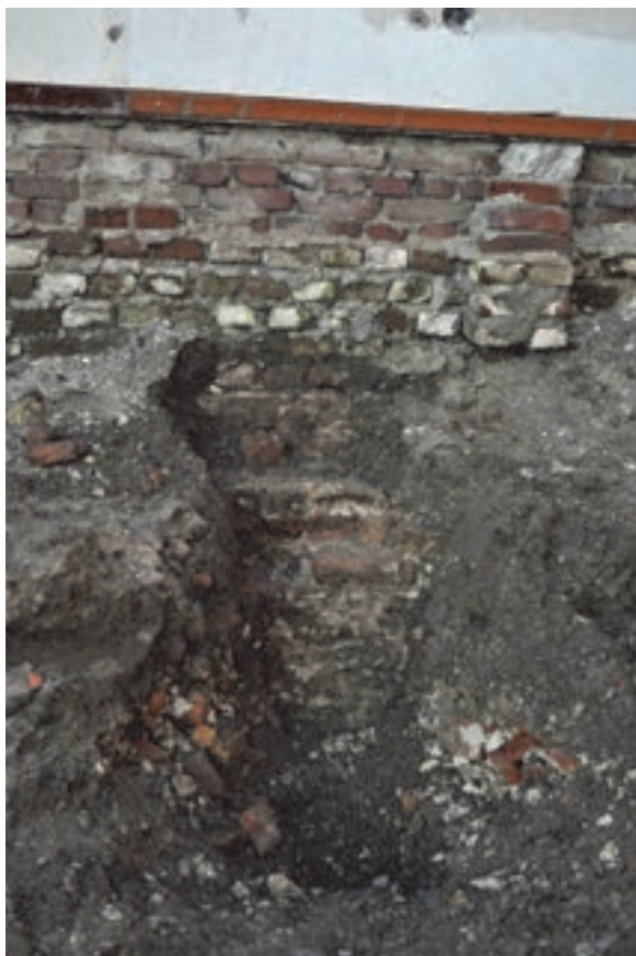
Afb. 5.22. Detail van het metselwerk van de noordmuur. Aangezien de fundering hier slechts op twee plaatsen voor een klein deel is vrijgelegd is over het metselwerk weinig mee te delen.
