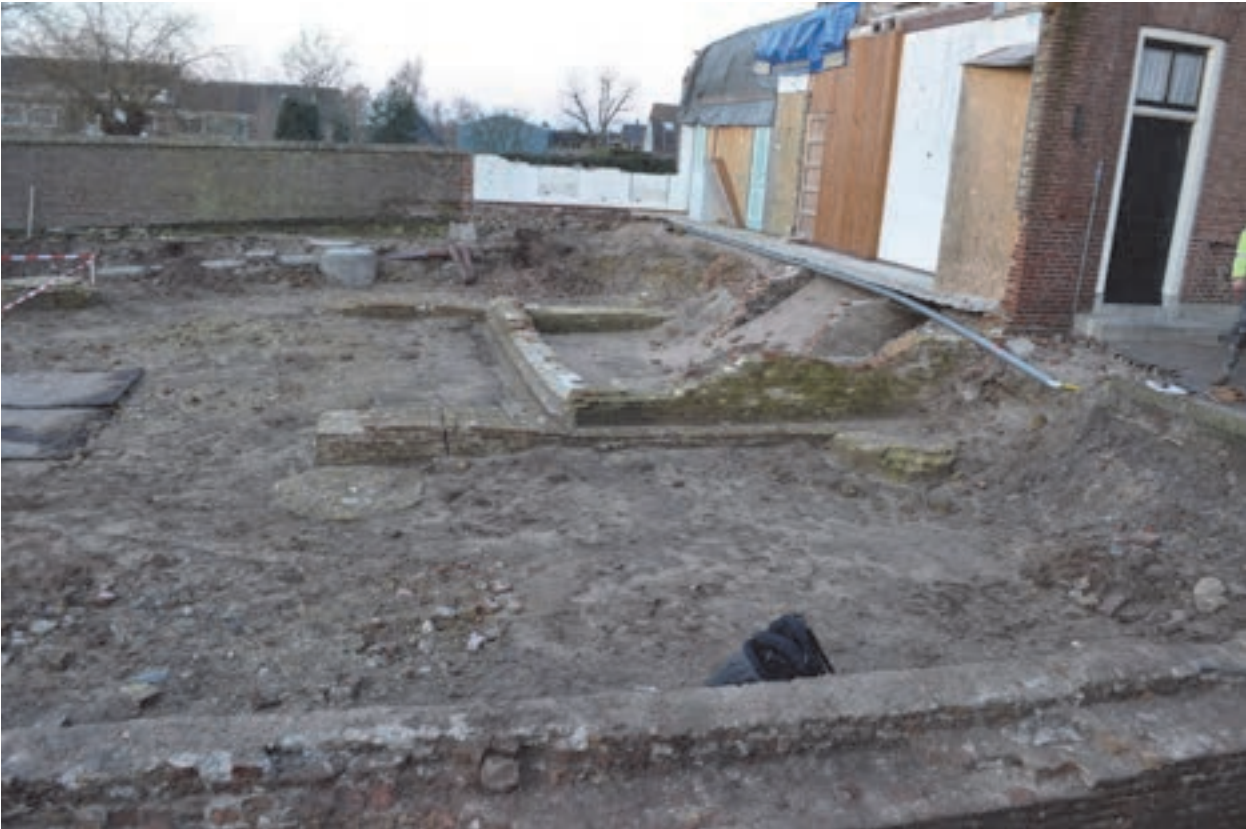
Afb. 5.31. Overzicht van de vrijgelegde funderingen van de consistoriekamer (midden foto). Het nog niet gesloopte deel is rechts op de foto zichtbaar. Opvallend is dat de noordelijke en zuidelijke fundering langer zijn dan het gebouw. Zie hiervoor ook de volgende afbeeldingen.
