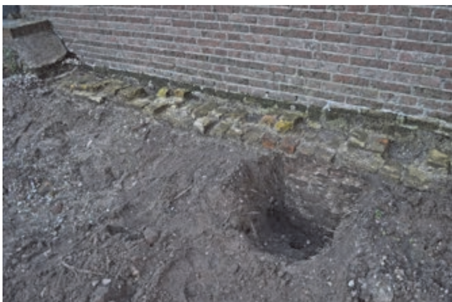
Afb. 5.23. Detail van de meest westelijke werkput tegen de binnenzijde van de noordmuur. Te zien is dat de kerkhofmuur op ouder metselwerk is geplaatst.
