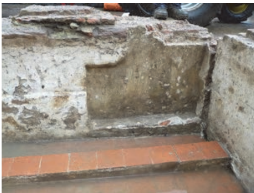
Afb. 5.29. Het inwendige van de grafkelder. In de noordwesthoek is het metselwerk verdiept uitgevoerd en aan de bovenzijde ontbreekt de aanzet voor de overwelling. Hier zal zich de toegang tot de kelderruimte hebben bevonden. In de hoek rechts is goed zichtbaar dat het metselwerk ter plaatse van de aansluiting op de westgevel is gescheurd.
