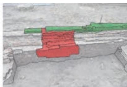
Afb. 5.13. Zicht op de drie westelijke steunberen tegen de zuidgevel. Bij de voorste steunbeer is de genoemde herstelfase goed te herkennen. De beide andere steunberen vertonen geen sporen van een herstelfase. Die bouwsporen zijn vermoedelijk bij de sloop van de kerk verloren gegaan.
