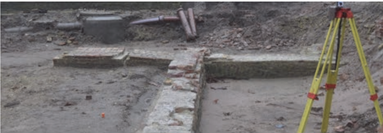
Afb. 5.31. Overzicht van de vrijgelegde funderingen van de consistoriekamer (midden foto). Het nog niet gesloopte deel is rechts op de foto zichtbaar. Opvallend is dat de noordelijke en zuidelijke fundering langer zijn dan het gebouw. Zie hiervoor ook de volgende afbeeldingen.
