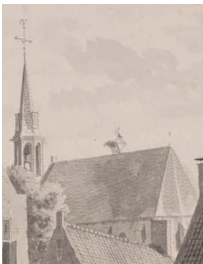
Afb. 5.4. Detail van een tekening van Abraham de Haen uit 1731 waarop de kerk vanuit het zuidoosten is getekend. De kap op het koor vormt geen geheel met de rest van de kerkkap. Het kerkdak is vijfzijdig gesloten. Ter plaatse van de overgang van koor naar schip is een vieringtoren te zien. Hoe deze op de kap van de kerk stond valt uit de tekening niet af te leiden vanwege de in de weg staande boom. (Herkomst: Topografie van Nederland, Universiteitsbibliotheek Leiden, P309_1No14).
