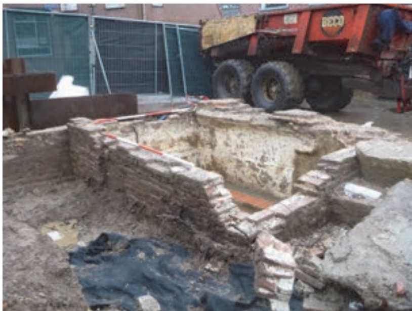
Afb. 5.28. De kelderruimte nadat deze was vrijgegraven.
