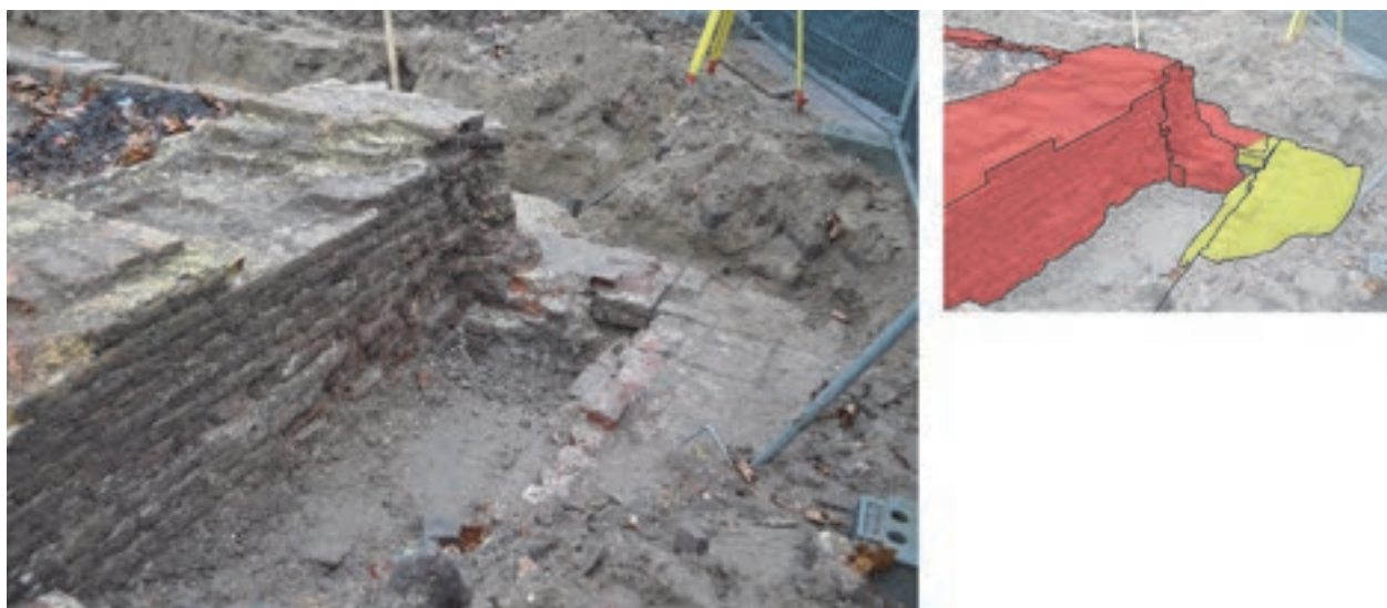
Afb. 5.20. Detail van de zuidwesthoek van het kerkgebouw. Op de inzet is in rood is het metselwerk van de kerk aangegeven. Vlak voor deze muur is de fundering van een tweede muur zichtbaar. Deze is in geel aangegeven. Dit metselwerk is, voor zover dat is na te gaan, tegen het oorspronkelijke metselwerk van de steunbeer geplaatst en betreft dus een latere toevoeging. Het gaat om een smalle aanbouw of steunmuur, die ook zichtbaar is op het oudste kadastrale minuutplan uit omstreeks 1830 en die de westgevel versterkt. Deze constructie zal dateren van na de verzakking van de westgevel.
