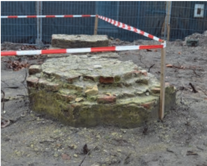
Afb. 5.24. Detail van één van de bakstenen kolommen van de kerk. Daarop is pleisterwerk aangebracht (op inzet in geel aangegeven). Niet alleen waren de kolommen gepleisterd, het pleisterwerk geeft ook aan dat het vloerniveau lager was dan het huidige maaiveld. Tevens is zichtbaar dat de kolom naar links toe overhelt (gele lijn op de inzet), terwijl de kolom erachter (in groen aangegeven) recht is blijven staan (tweede gele lijn).
