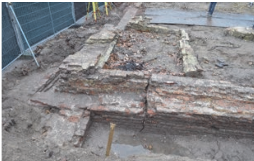
Afb. 5.15. Het meest westelijke deel van de zuidmuur. In het midden van de foto is een brede verticale scheur zichtbaar. Deze zal verband houden met een verzakking van de westgevel. Het metselwerk links van de scheur is naar het westen toe verzakt. Waarschijnlijk heeft deze verzakking tot gevolg gehad dat men de westgevel moest versterken.
