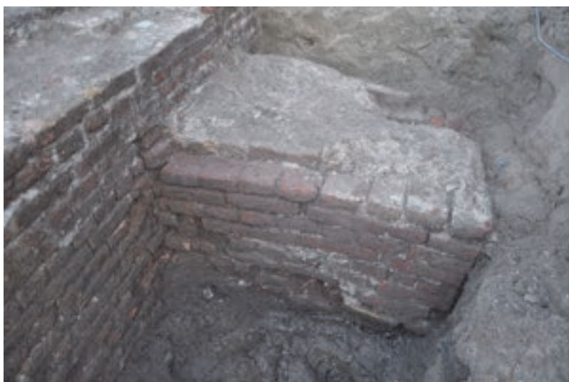
Afb. 5.12. Zicht op de meest oostelijke steunbeer van de zuidgevel. In het metselwerk van de steunbeer zijn twee fasen te onderscheiden. Het onderste deel en de kern van de steunbeer stammen nog uit de bouwtijd van het kerkship (in rood aangegeven). Te zien is dat dit metselwerk ter plaatse van de steunbeer is verzakt. Bij het herstel is het bovenste deel van de steunbeer vervangen (in groen aangegeven). Het bovenste deel van de zuidmuur (in geel aangegeven) is niet van steunberen voorzien. Aangezien de steunberen op het oudste kadastrale minuutplan nog zijn getekend zal dit metselwerk dus jonger zijn dan ca. 1830. Waarschijnlijk betreft dit (hergebruikte) baksteenwerk de onderbouw van de muur rond de voormalige kerk in de tijd dat deze fungeerde als kerkhof.
