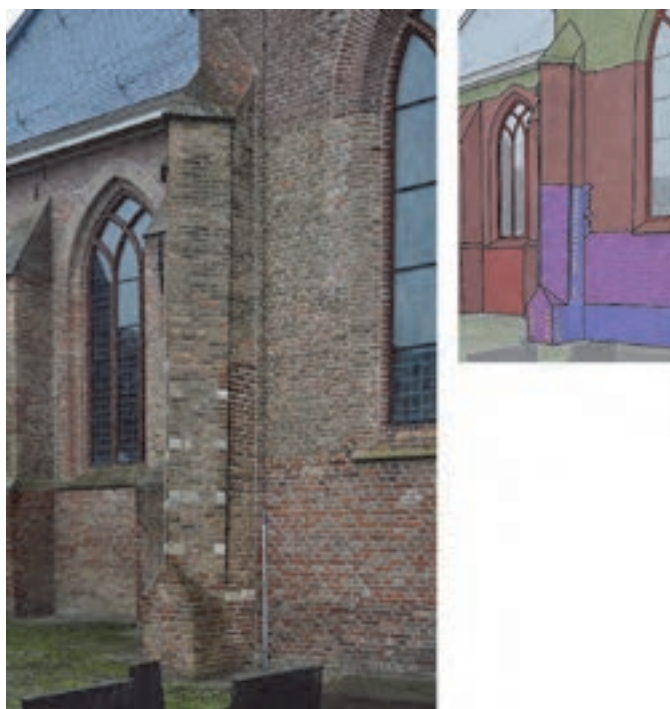
Afb. 5.9. Detail van de noordoosthoek van het oude transept. Hierin zijn meerdere bouwfasen te onderscheiden. In de inzet is in blauw het oudste deel van het metselwerk aangegeven. Gezien de vormgeving en detaillering is het metselwerk van de steunbeer te dateren in de 16 e eeuw. Waarschijnlijk is de kerk na verzakkingen in de 16 e eeuw grotendeels herbouwd op de bestaande funderingen. Het bruin gekleurde deel zal een latere herstelling zijn. In groen is metselwerk uit 1832 aangegeven. Bij de delen in paars en rood is veel metselwerk vervangen tijdens de 20 e -eeuwse restauraties.
