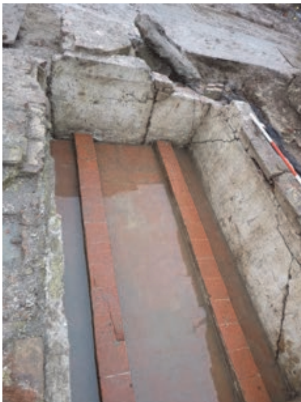
Afb. 5.30. De grafkelder gezien naar het noorden. De twee rijen tegels dienden om er de grafkisten op te plaatsen. Geheel rechts is nog net de aanzet van het gewelf zichtbaar. De kopse noordwand is aan de linkerkant losgescheurd van het metselwerk bij de westgevel, dit als gevolg van het verzakken van die gevel. Rechts van het midden is een verticale naad zichtbaar. Gezien het strakke, rechte verloop is dit waarschijnlijk een bewuste verticale naad. Het gewelf loopt niet door tot aan de noordwand van de kelder, maar eindigt ongeveer een meter ervoor. Zoals we eerder al zagen zal de toegang tot de kelderruimte zich hier hebben bevonden.
