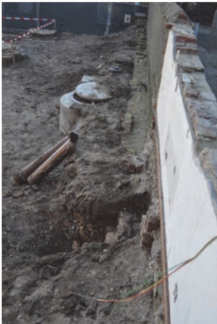
Afb. 5.21. Overzicht van de fundering van de noordmuur, gezien in westelijke richting. Boven in beeld is te zien dat naderhand op de helft van de fundering de smallere muur rond het kerkhof is gebouwd.
