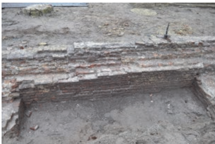
Afb. 5.14. De tweede travee van de zuidmuur, gerekend vanaf het westen. In het midden van de muur is een deel van het metselwerk naderhand dichtgezet. Dit deel is op de inzet in rood aangegeven. Hier heeft zich in het verleden een toegang tot de kerk bevonden. Het op de inzet groen gekleurde metselwerk is in een nog jongere fase tot stand gekomen.
